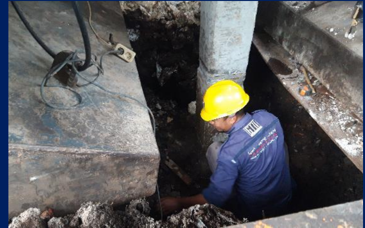
Persiapan Test Tiang Pancang
