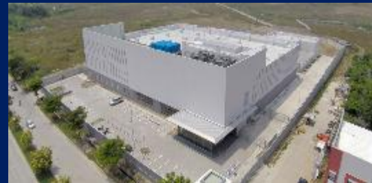
GTN Data Center - Cikarang
