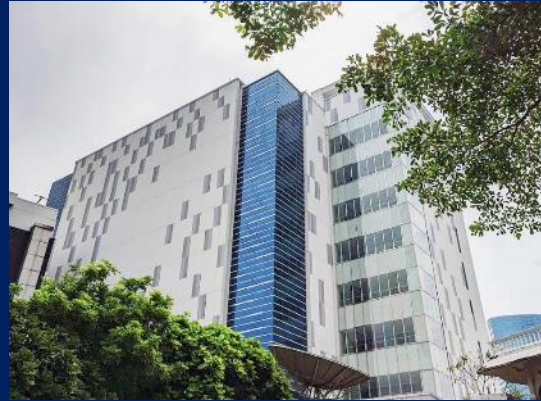
JKT 02 Data Center - Jakarta
