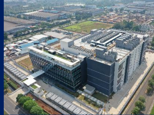
JKT 03 Data Center - Cibitung
