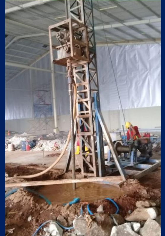
Pengecoran Borepile
